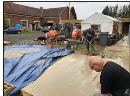
Travaux de mise aux normes ERP
