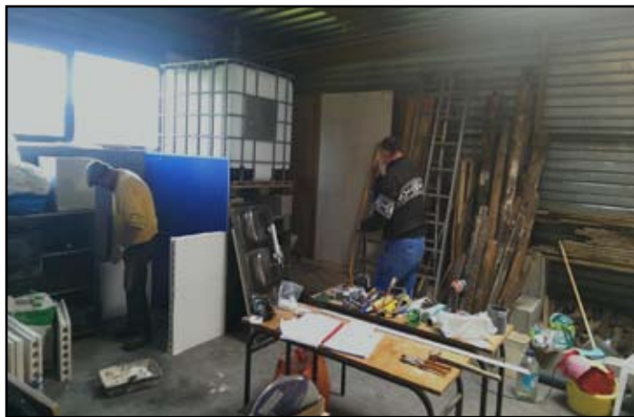
En plein travaux à l'intérieur...
