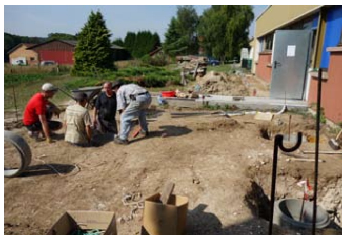
Travaux extérieurs sur la future aire d'observation
